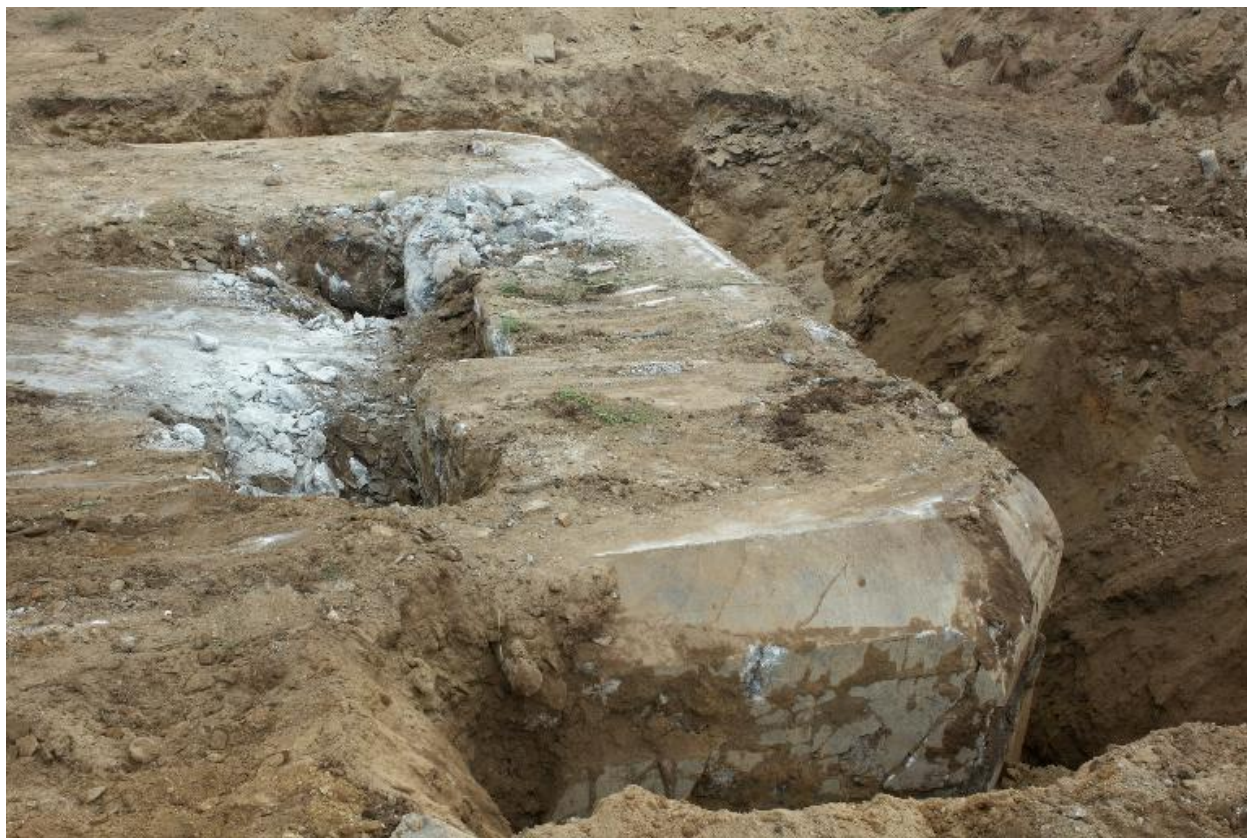
Déconstruction d'un bunker de type 502
