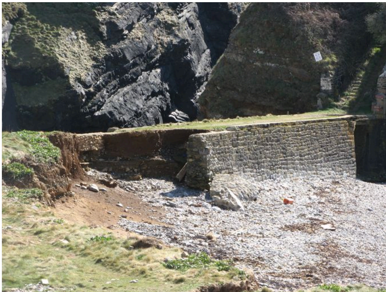
Digue permettant l'accès à l'îlot du Diable
