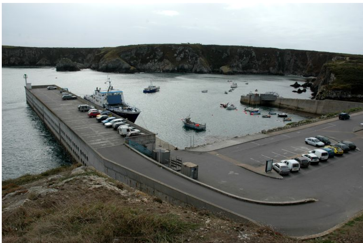
Vue générale du port-abri du Stiff
