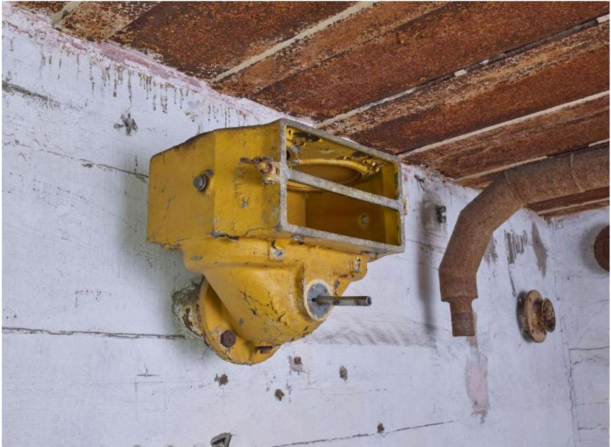
Vue du filtre dépoussiéreur de la salle de ventilation (la plaque constructeur a disparu)
