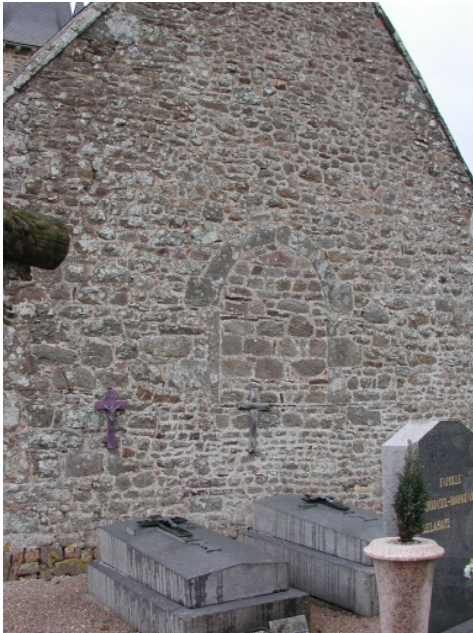
Vue extérieure du chevet, détail d'une ouverture murée
