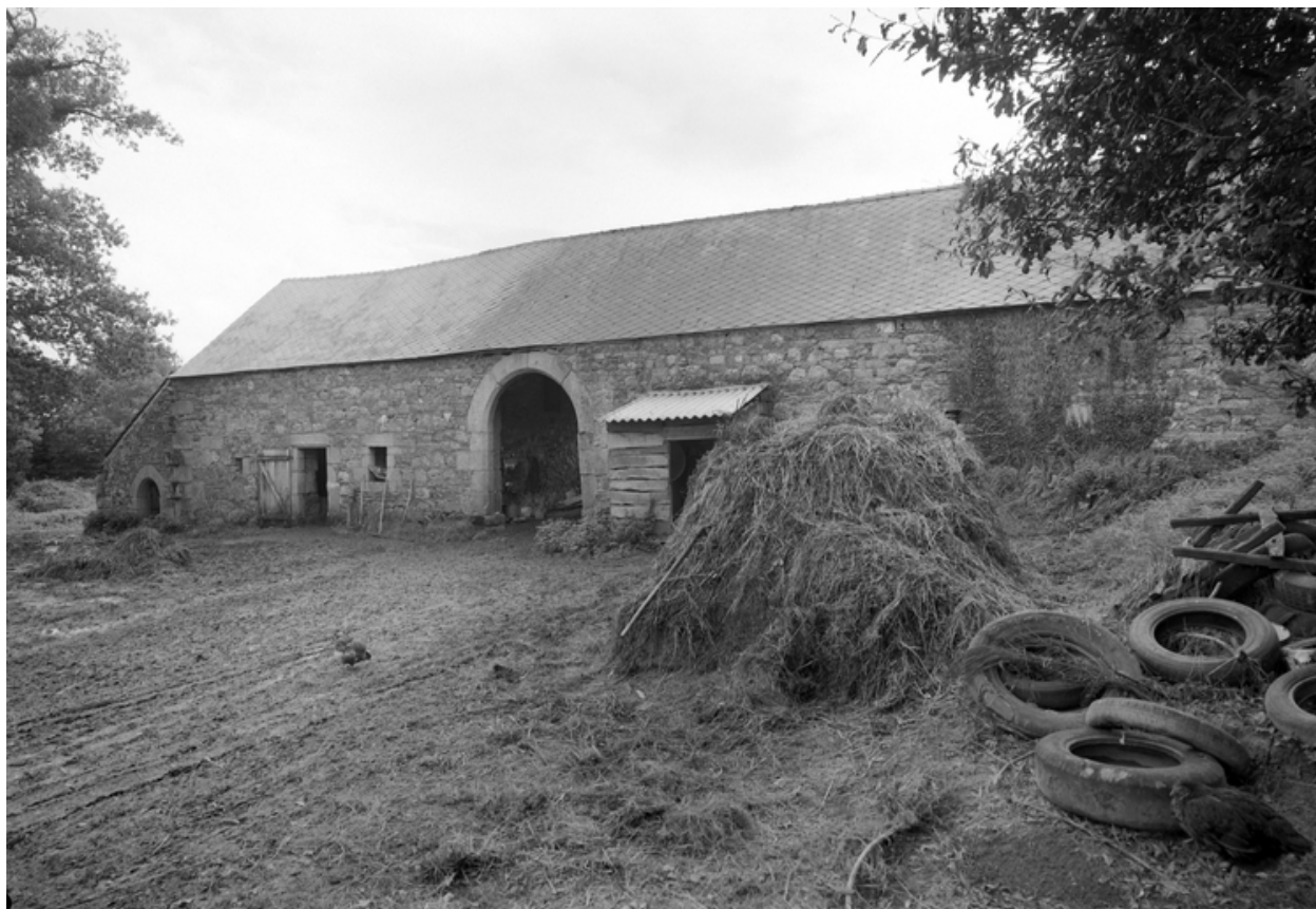
Bâtiments de commerces sud-est - face nord
