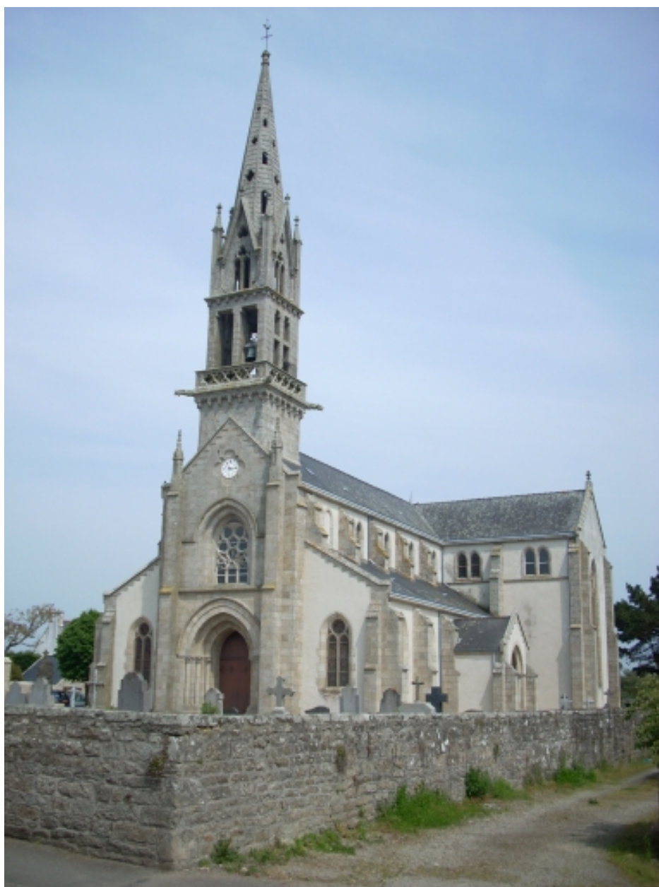
Plobannalec, église paroissiale Saint-Alour : vue générale sud-ouest
