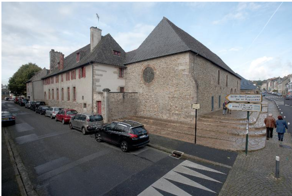
Vue générale sud-est du couvent des Capucins
