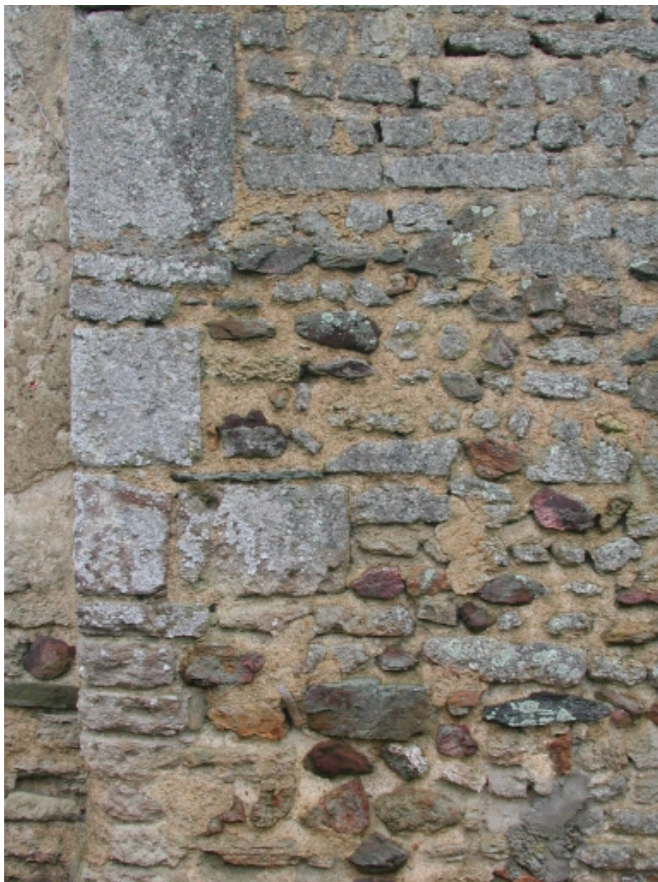
Détail ; chaînage d'angle en calcaire coquillier
