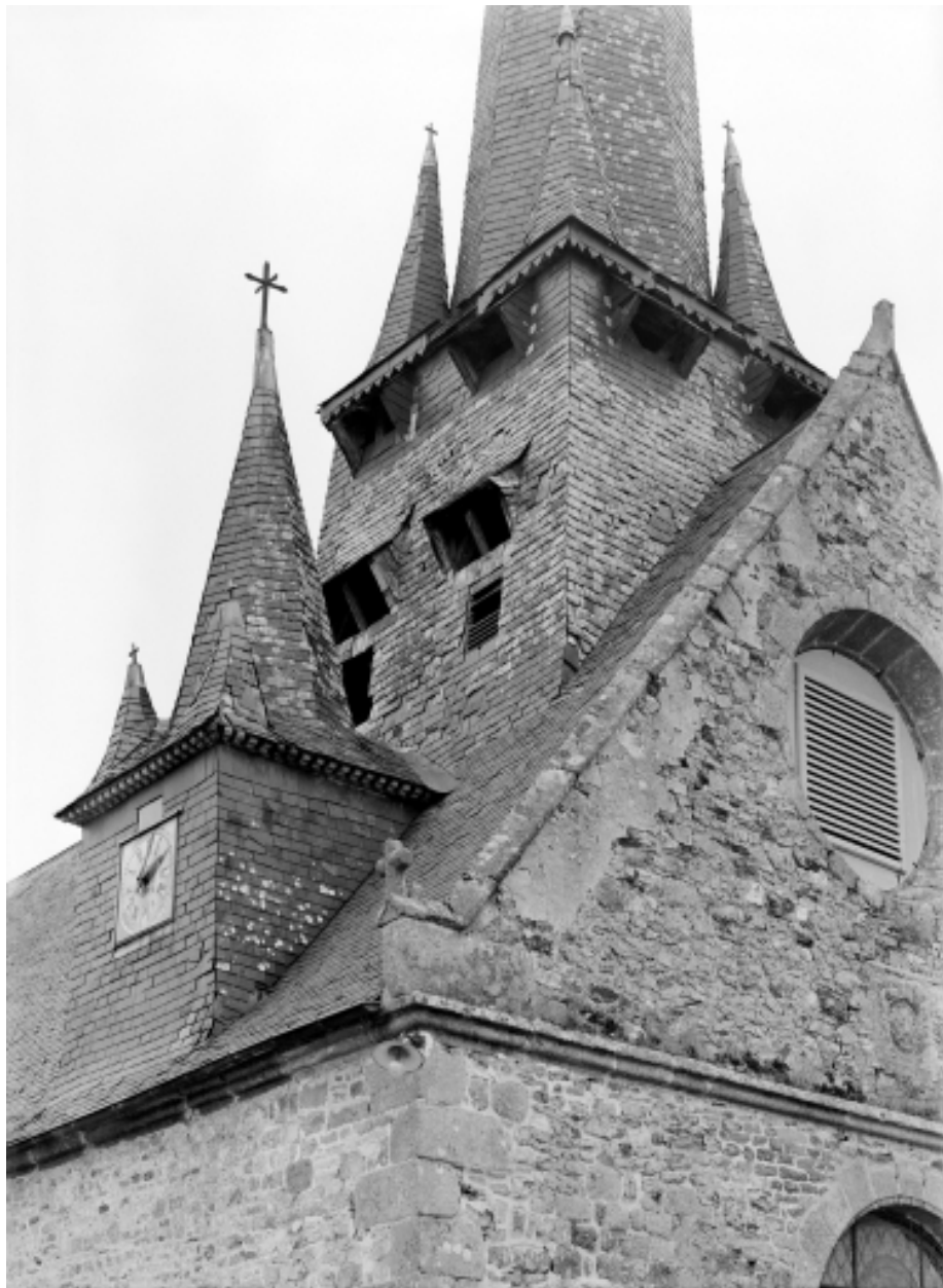
Clocher, chambre des cloches et clocheton, partie nord-est : vue générale
