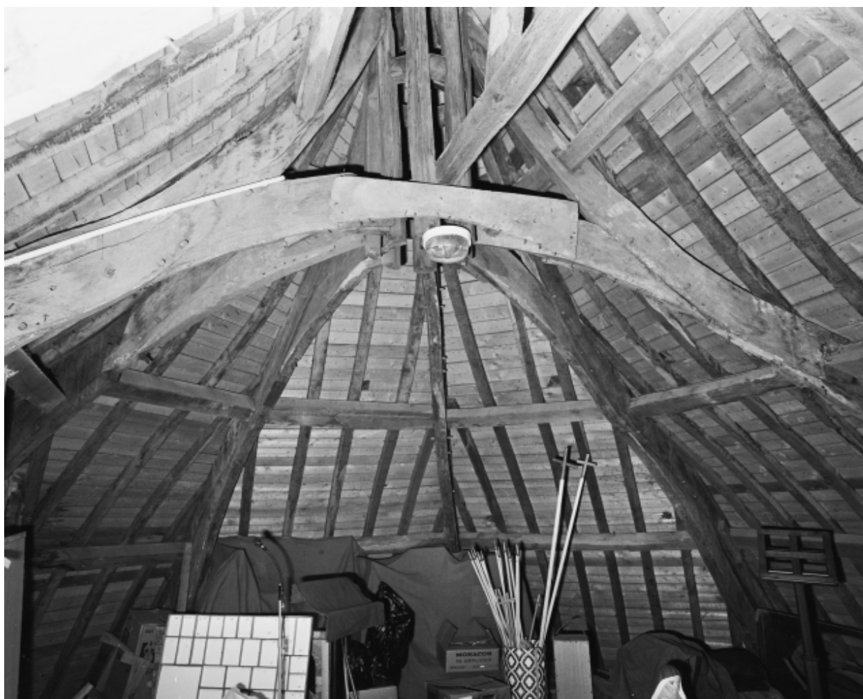
Sacristie sud : charpente
