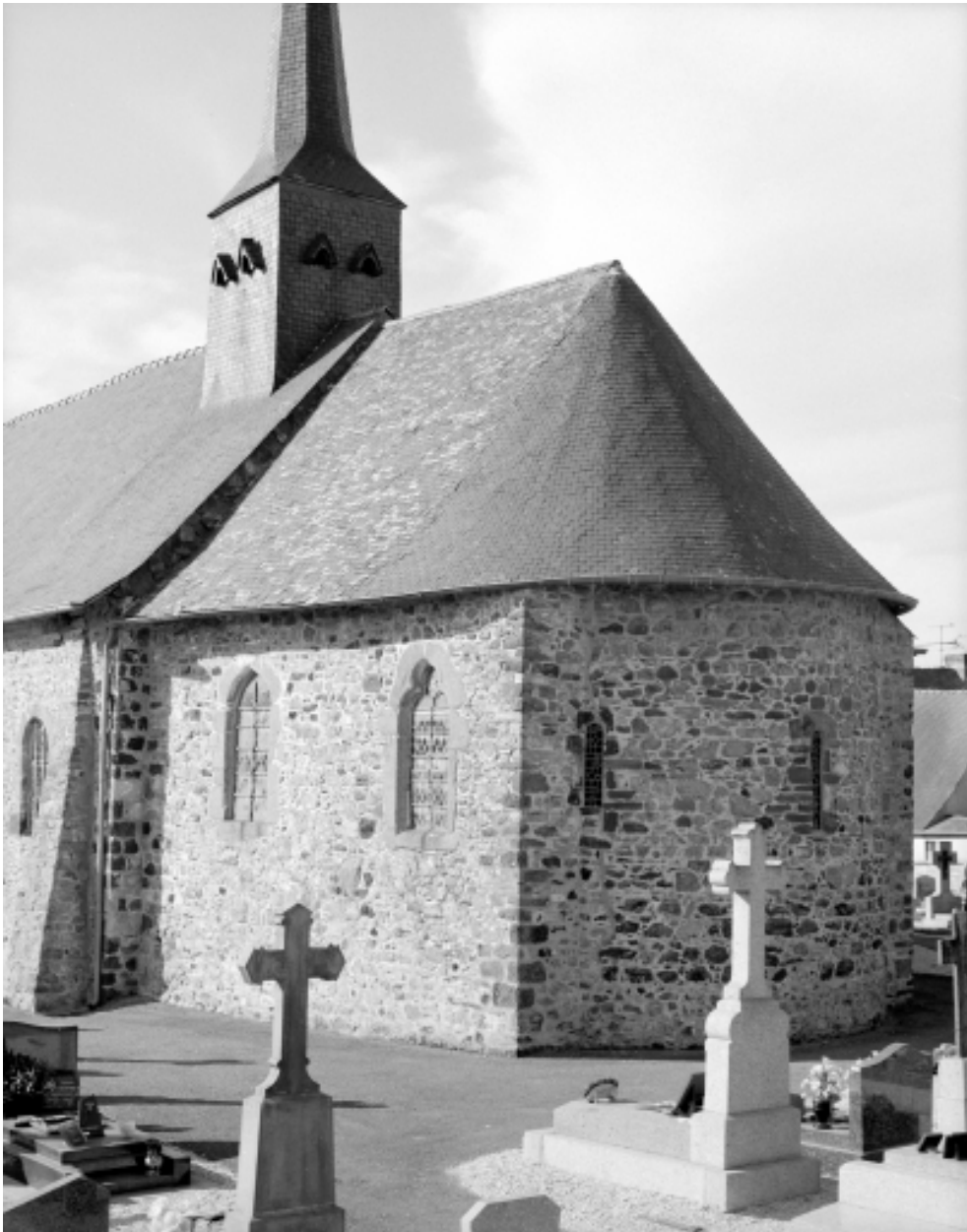
Chevet, élévation sud-est : vue générale.
