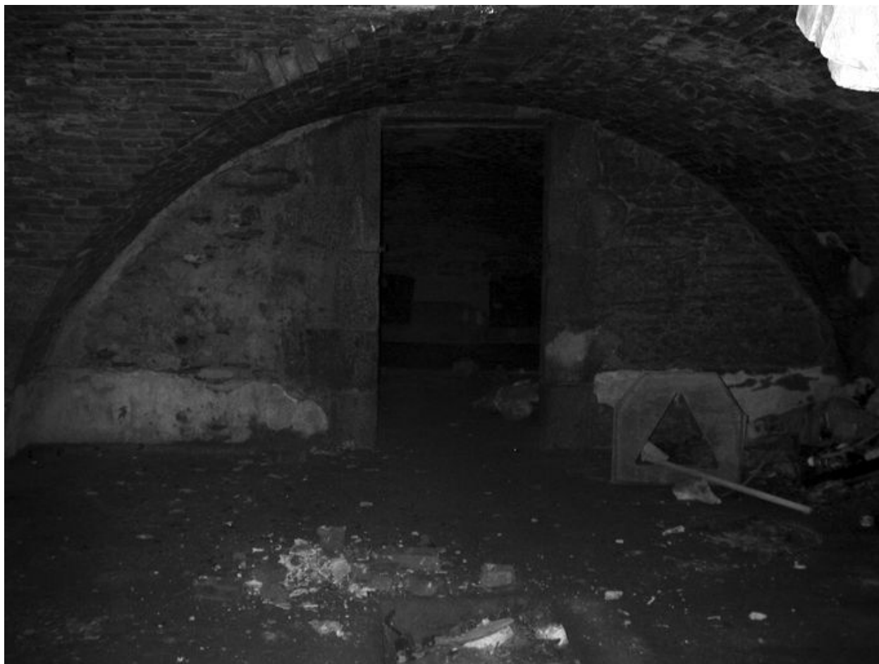
Roscanvel, pointe de Cornouaille : tour-modèle n° 1, premier niveau voûté en briques, pilier central
