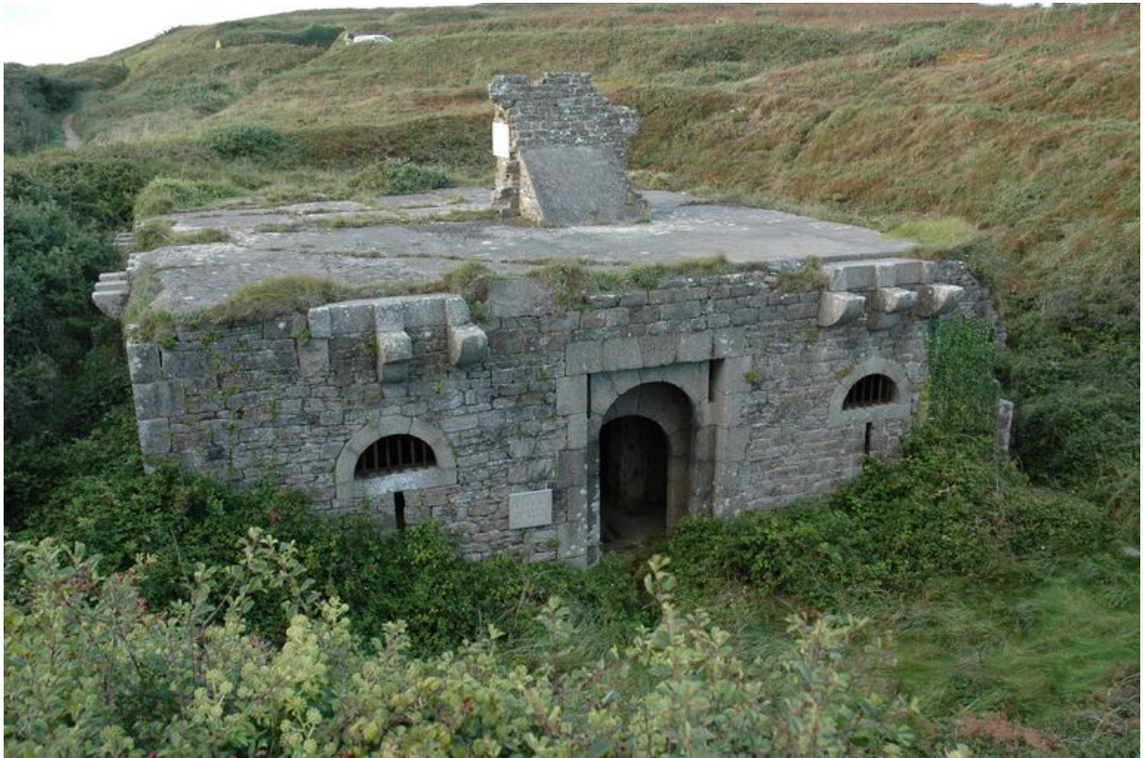
Vue générale depuis le sud (état en 2006)
