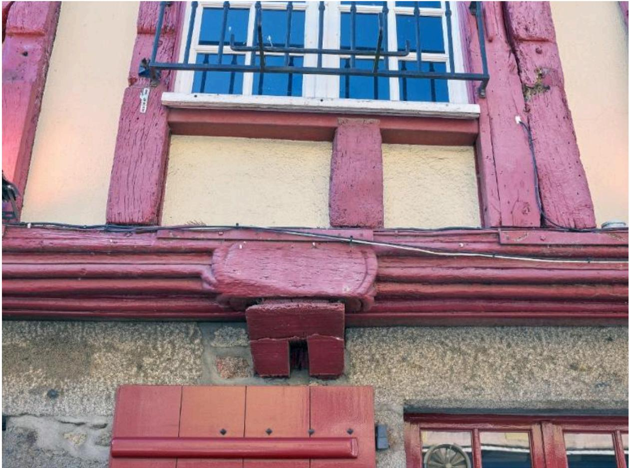
La sablière de chambrée s'orne d'une série de moulures qui s'arrêtent au niveau de son assemblage avec les abouts de solive.
