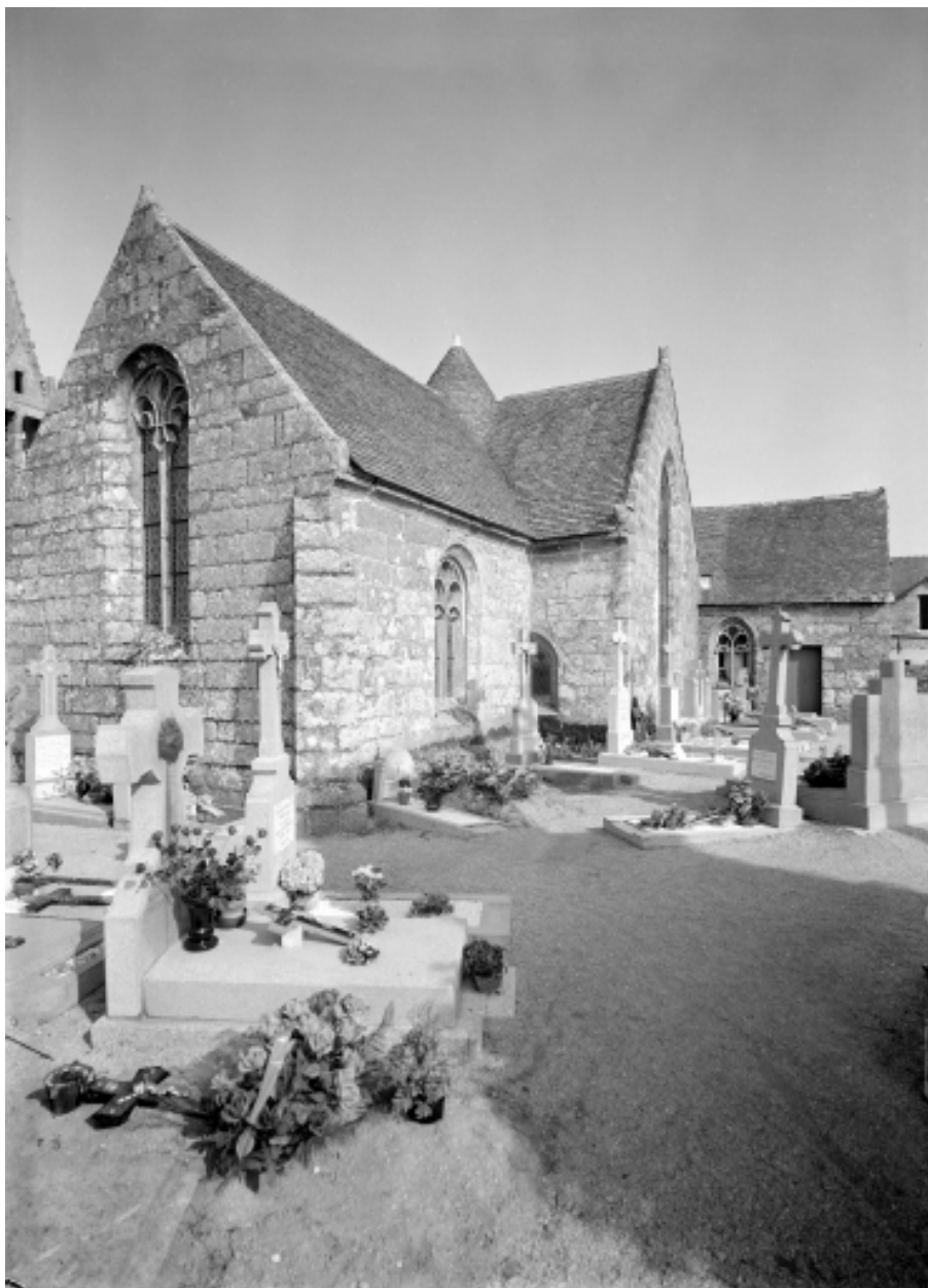
Bras sud et chœur, vue prise du sud-est
