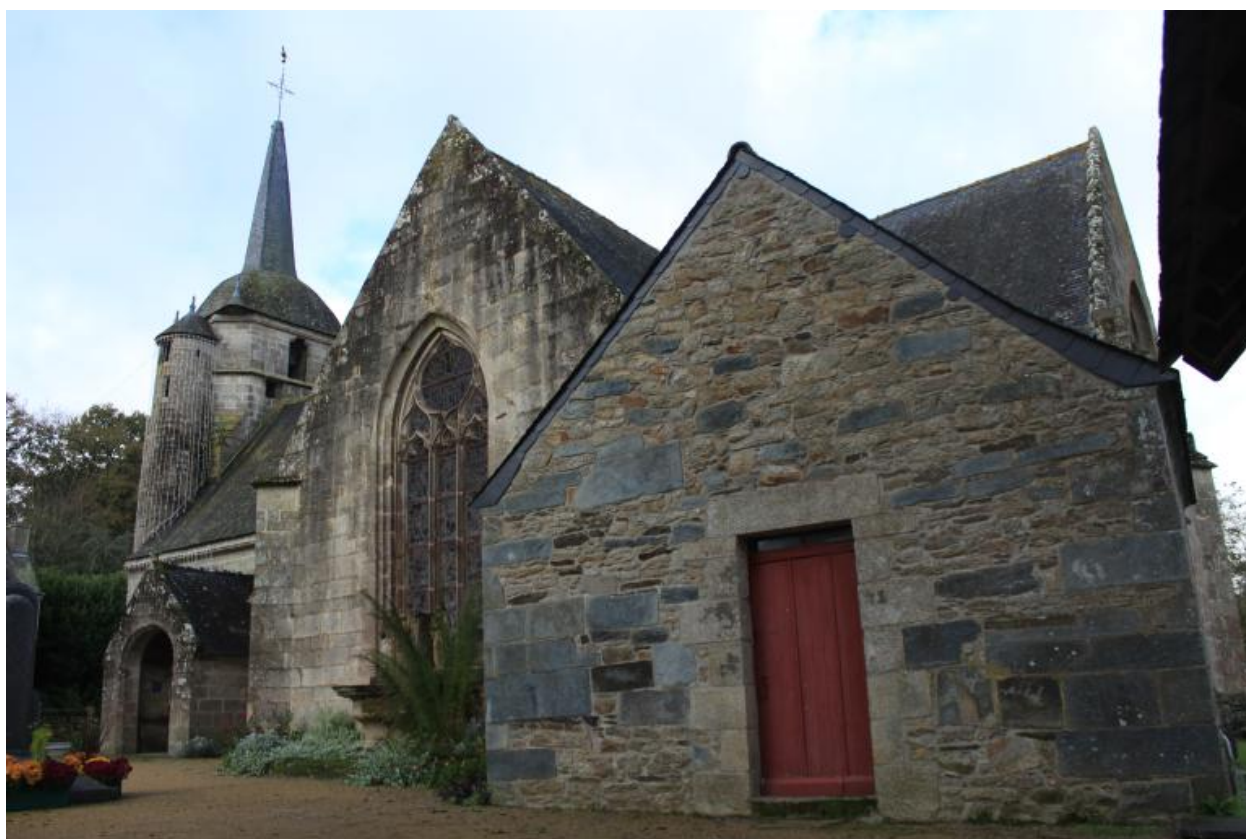
Eglise Saint-Mériadec, Pontivy, façade sud.
