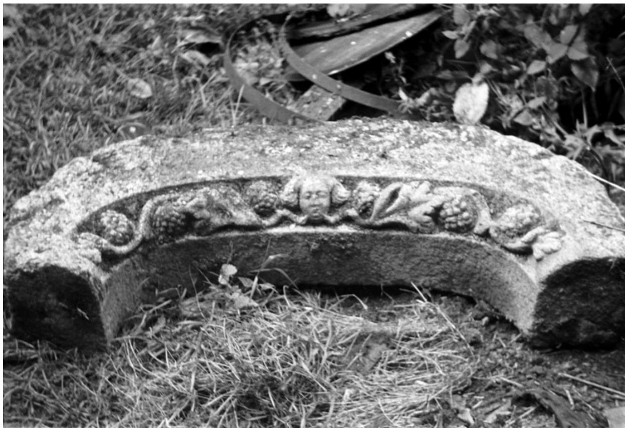
Façade nord, tourelle : détail du linteau, au sol
