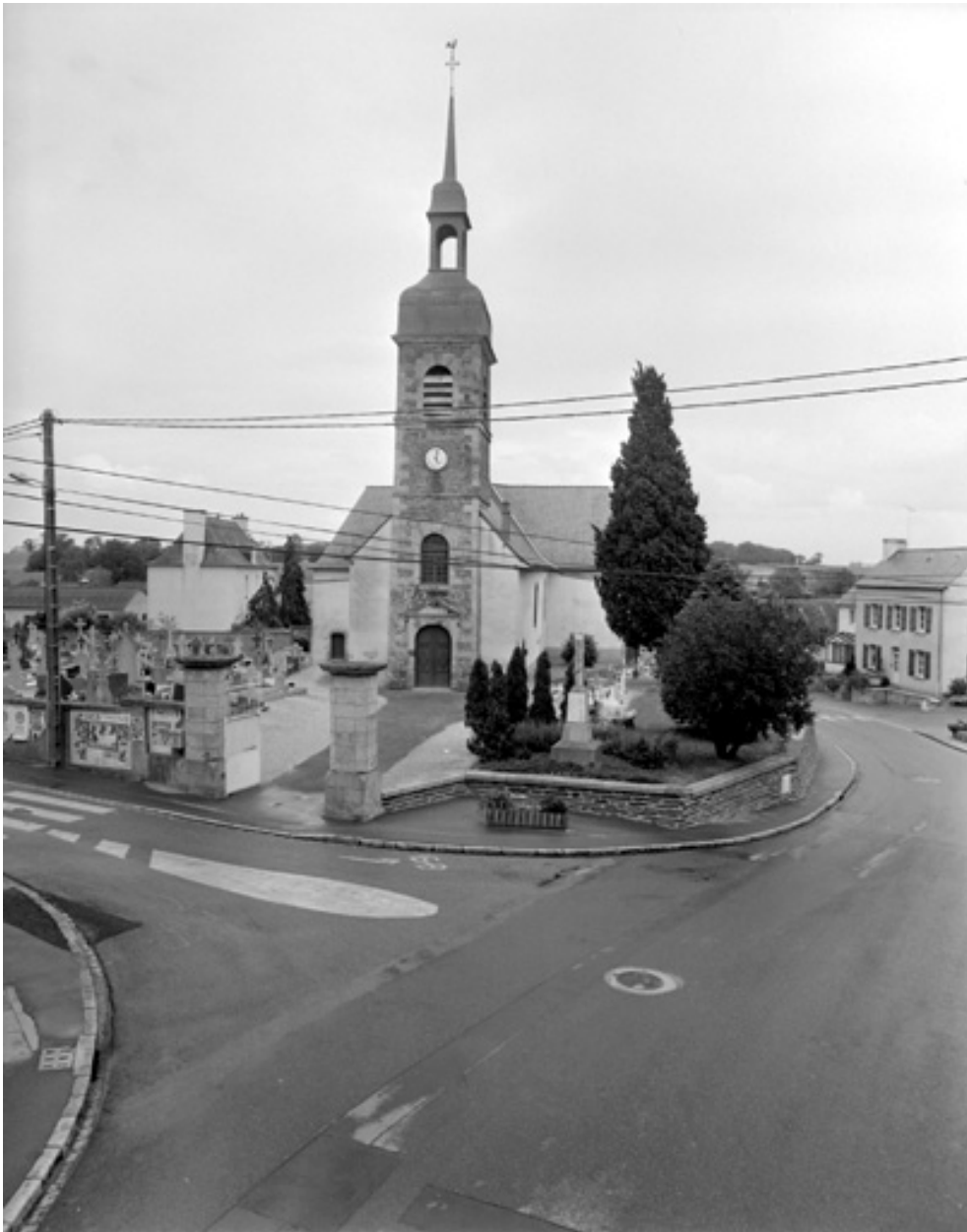
Elévation ouest : vue générale
