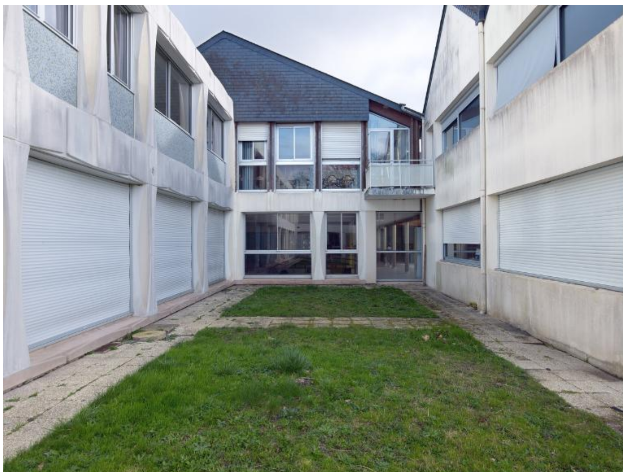
Façade sud-ouest des anciens préau et réfectoire (Yves Guillou, architecte, 1980). A gauche, façade de l'externat, à droite, pignon d'une extension de l'externat.
