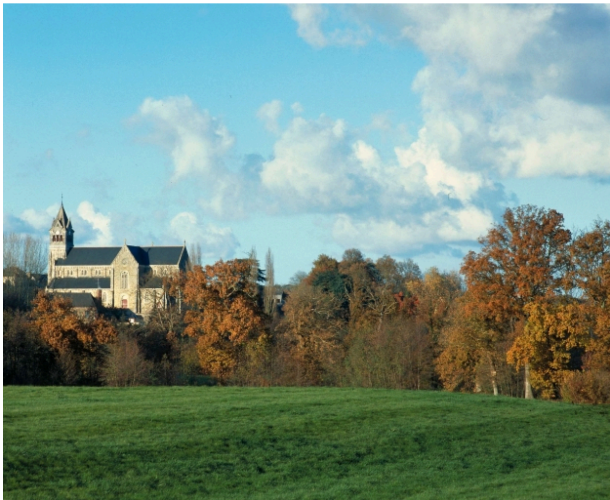
Vue de situation sud
