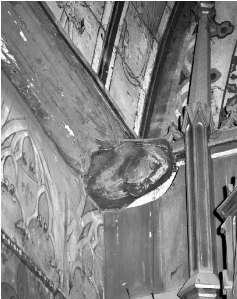
Intérieur, sablières : vue de détail d'un blochet.
