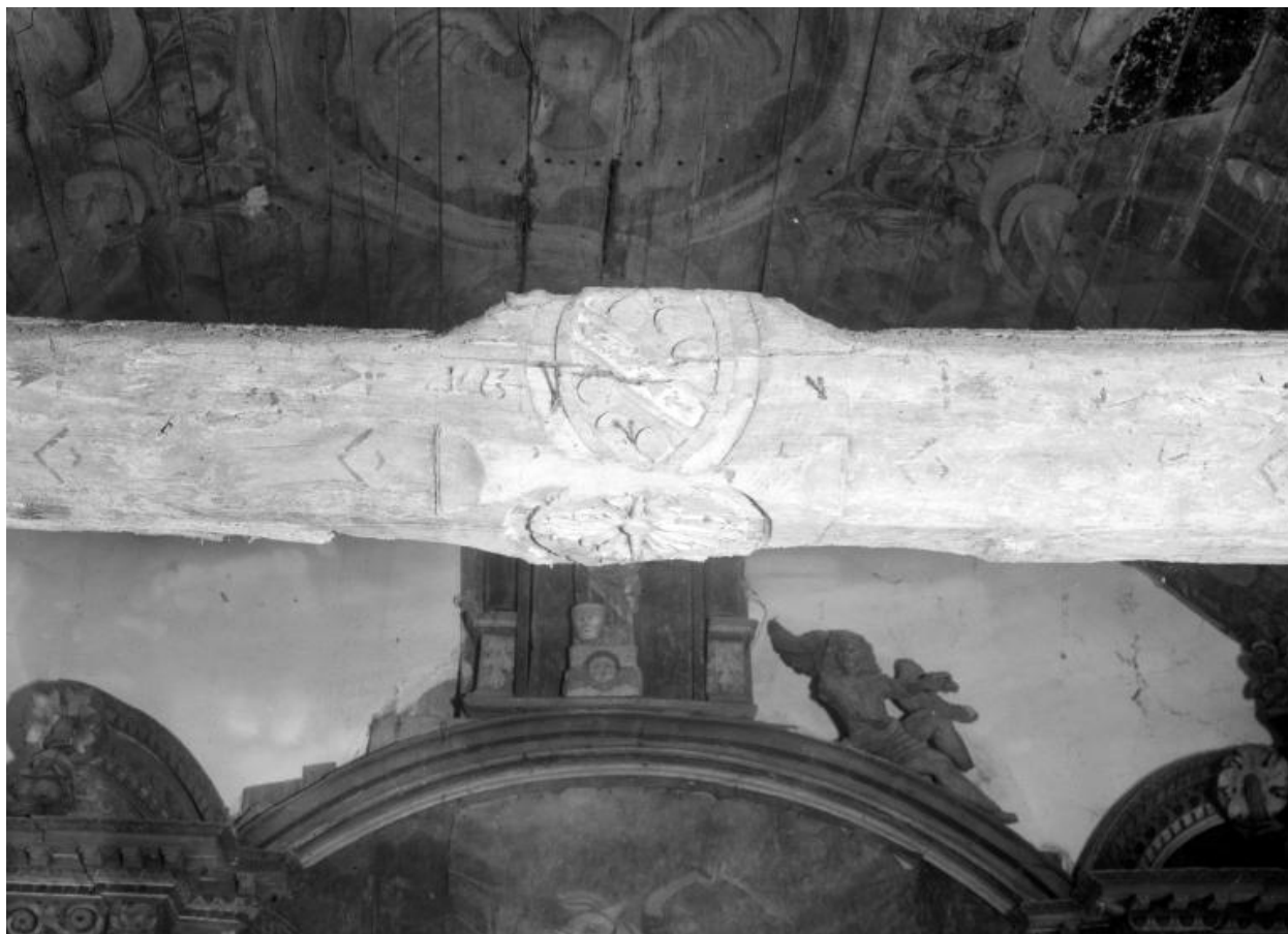
Charpente : détail d'un entrain armorié daté 1623
