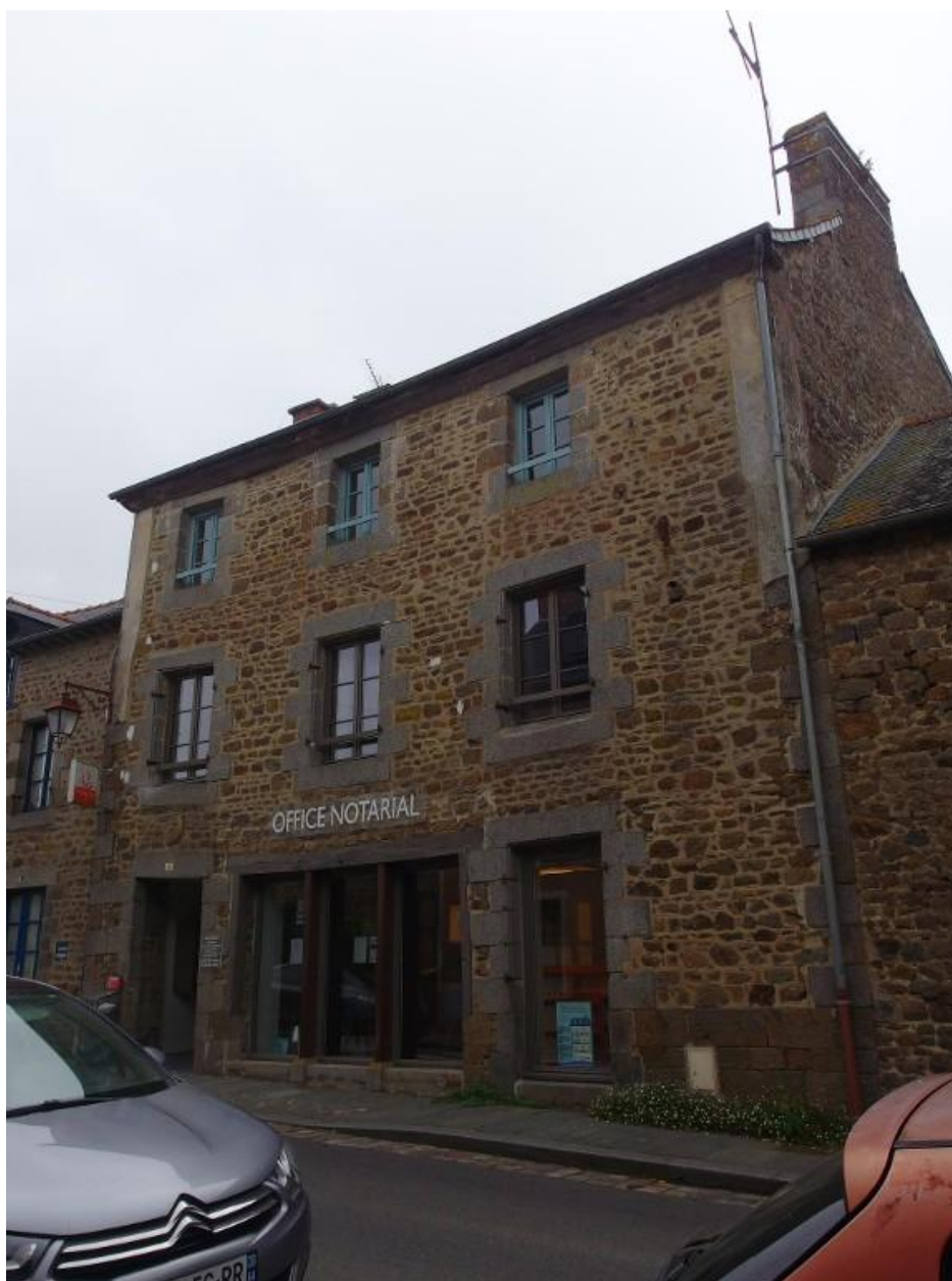
Vue de la façade est
