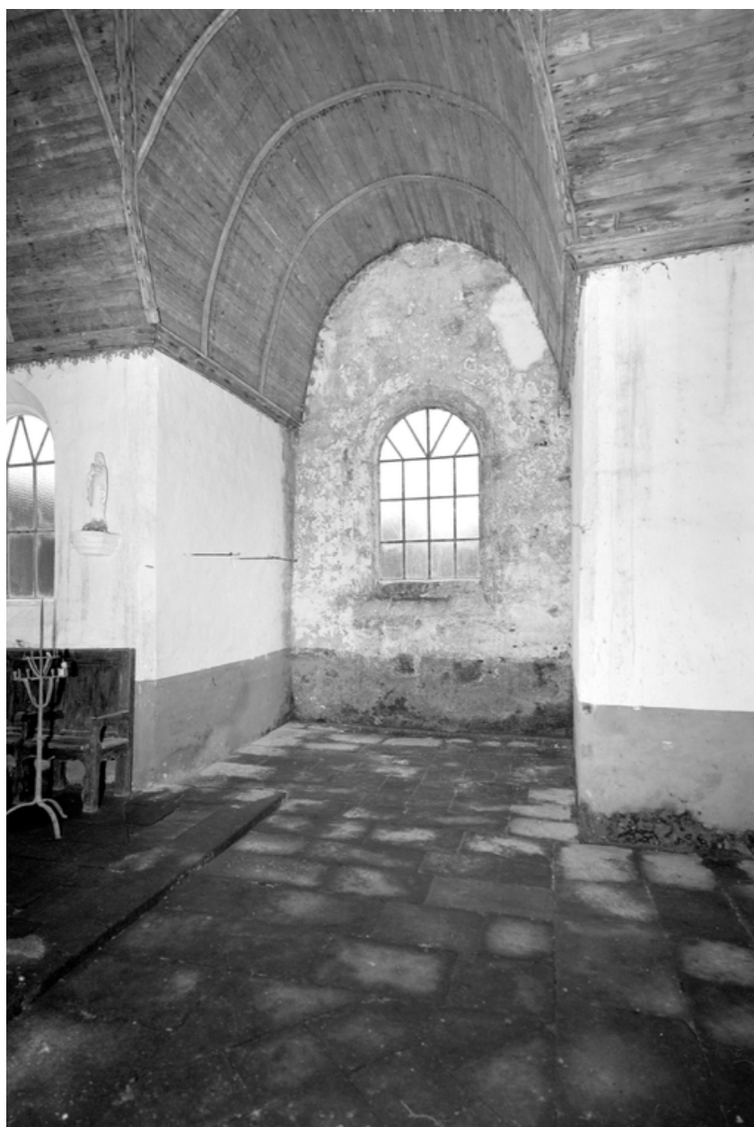
Vue du bras sud du transept
