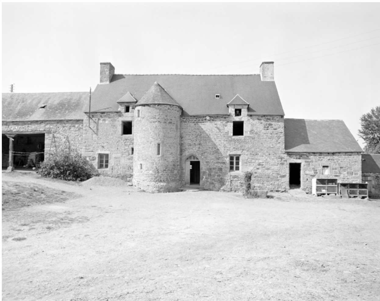
Vue générale de la façade sud
