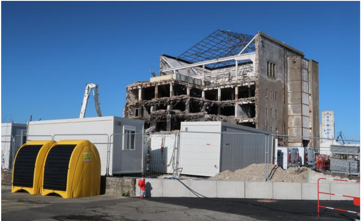
Déconstruction de l'ancien frigorifique, 10 mars 2022 : côté ouest et façade sud avec parement de moellon et enduit encore debout
