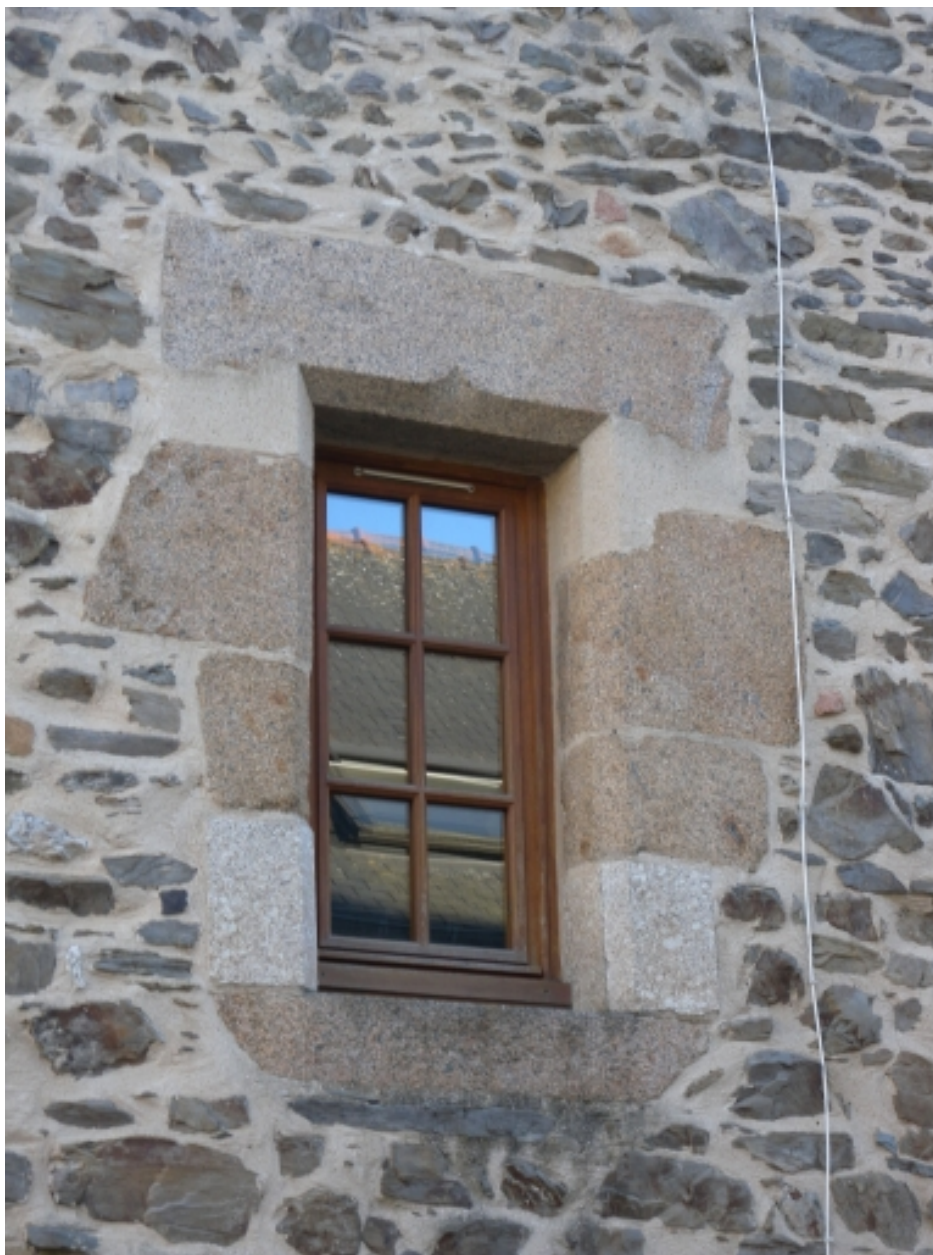
Détail d'une ouverture du 15ème ou 16ème siècle, rue des Frères Durand
