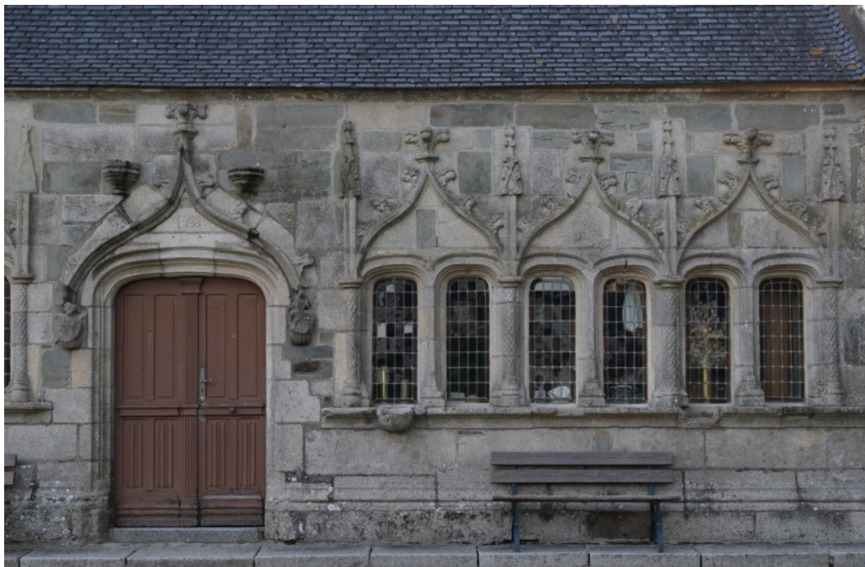
Ossuaire, élévation est, détail des ouvertures
