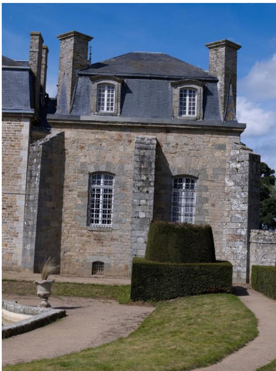
Vue de l'élévation orientée vers le sud-est : détail du charrier encadré de contreforts
