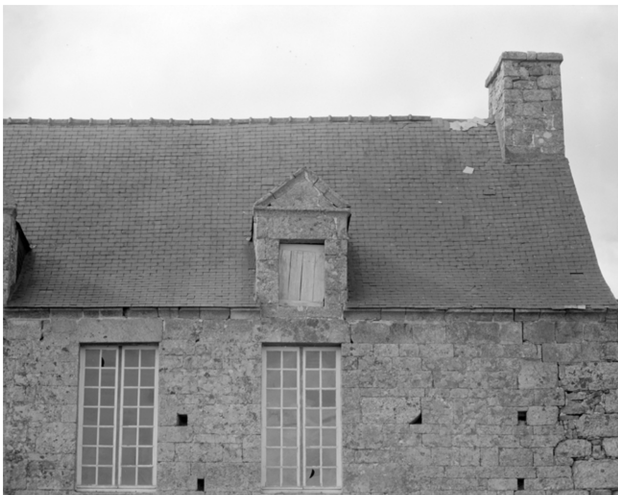
Façade sud : lucarne est
