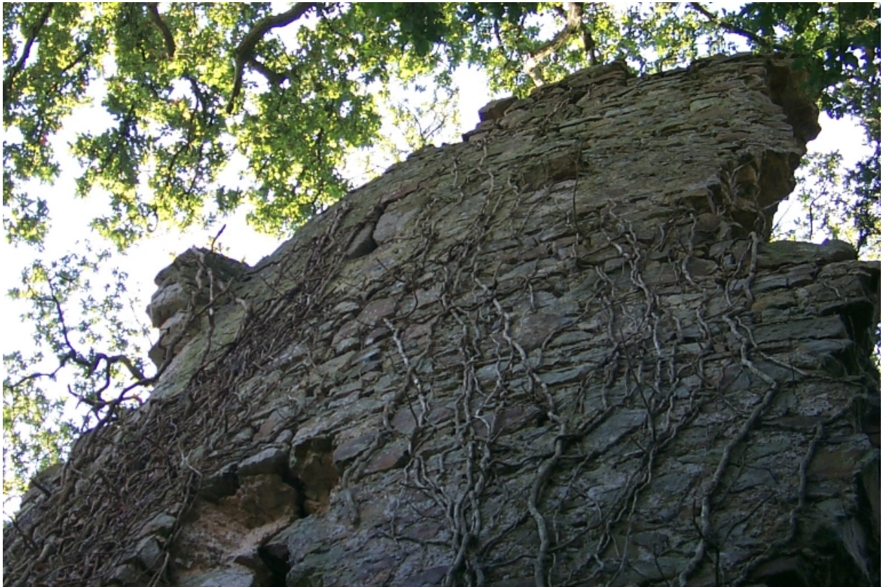
Le donjon en ruines, parement extérieur : vue partielle nord-ouest
