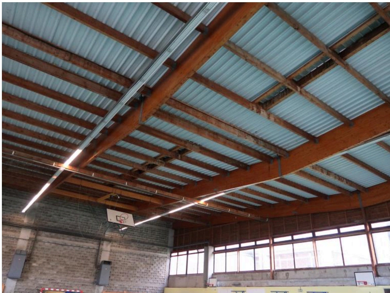
Détail de la charpente
