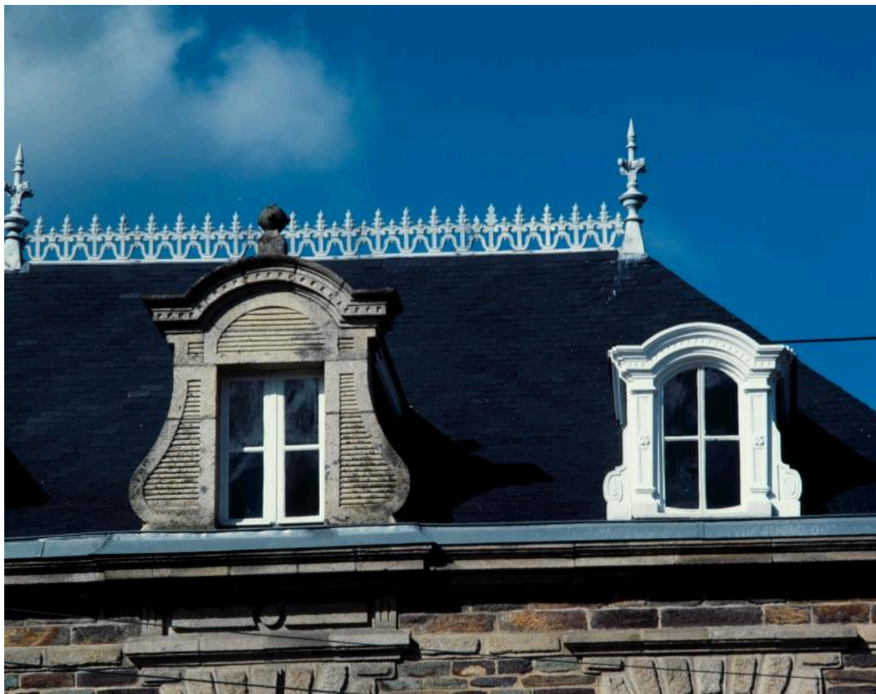
2, faubourg Sainte-Anne, immeuble du début du 20e siècle : les lucarnes (état en 1988)
