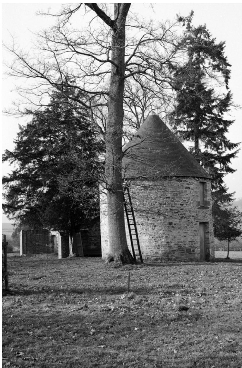
Tour ouest, vue générale.
