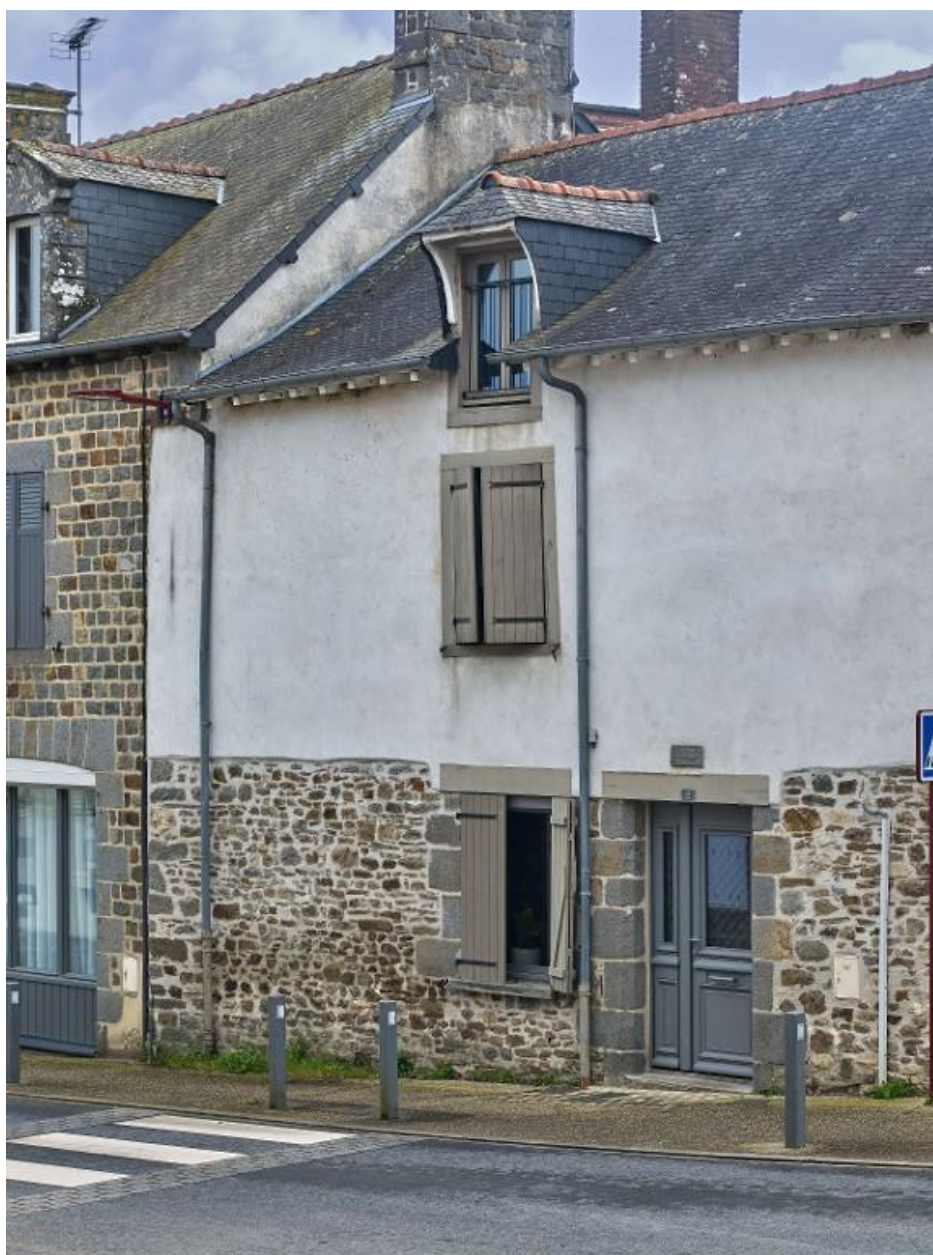
Elévation antérieure, détail des ouvertures.
