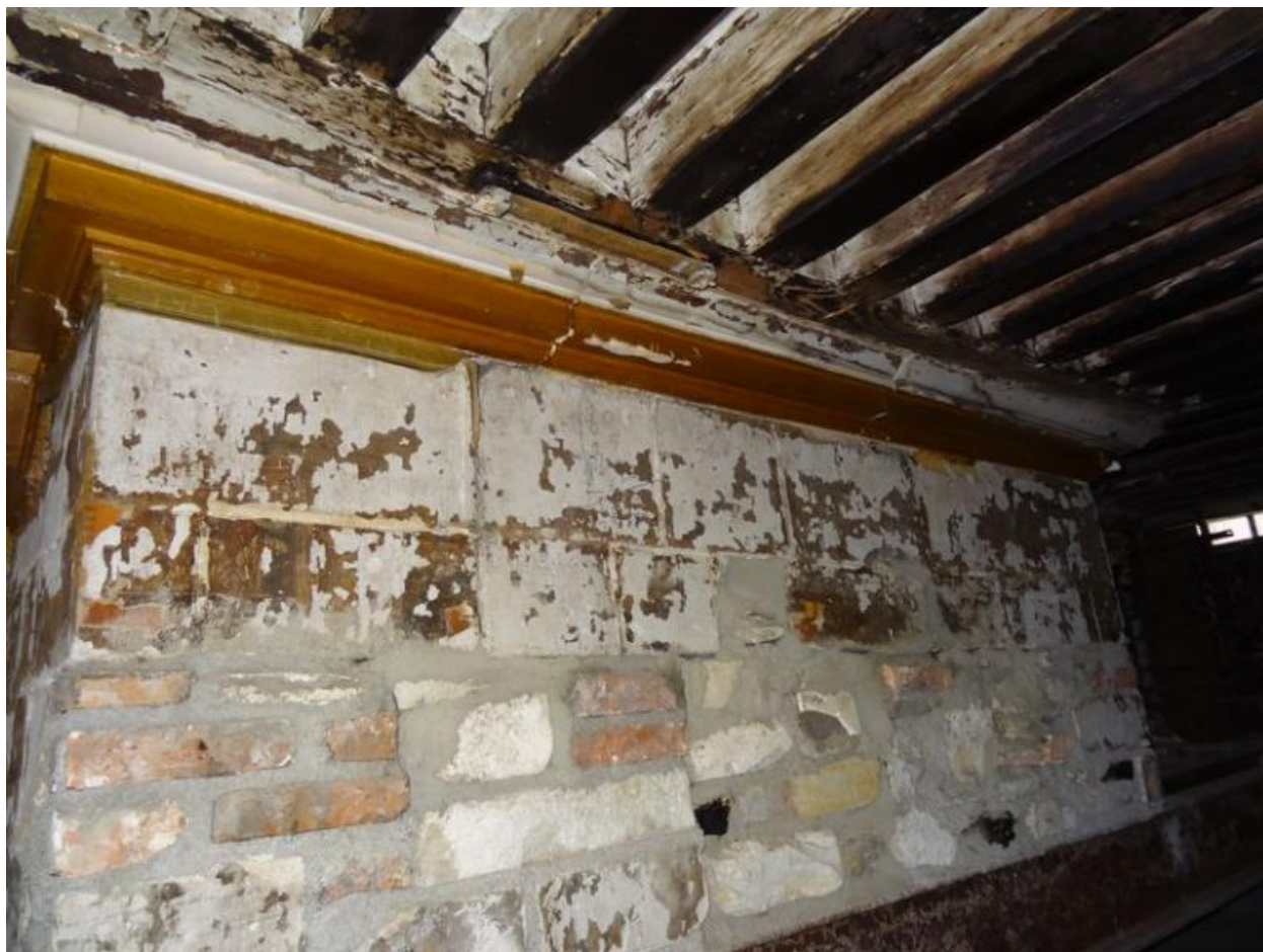
Sommet de la hotte de l'ancienne cheminée de la salle sud du rez-de-chaussée
