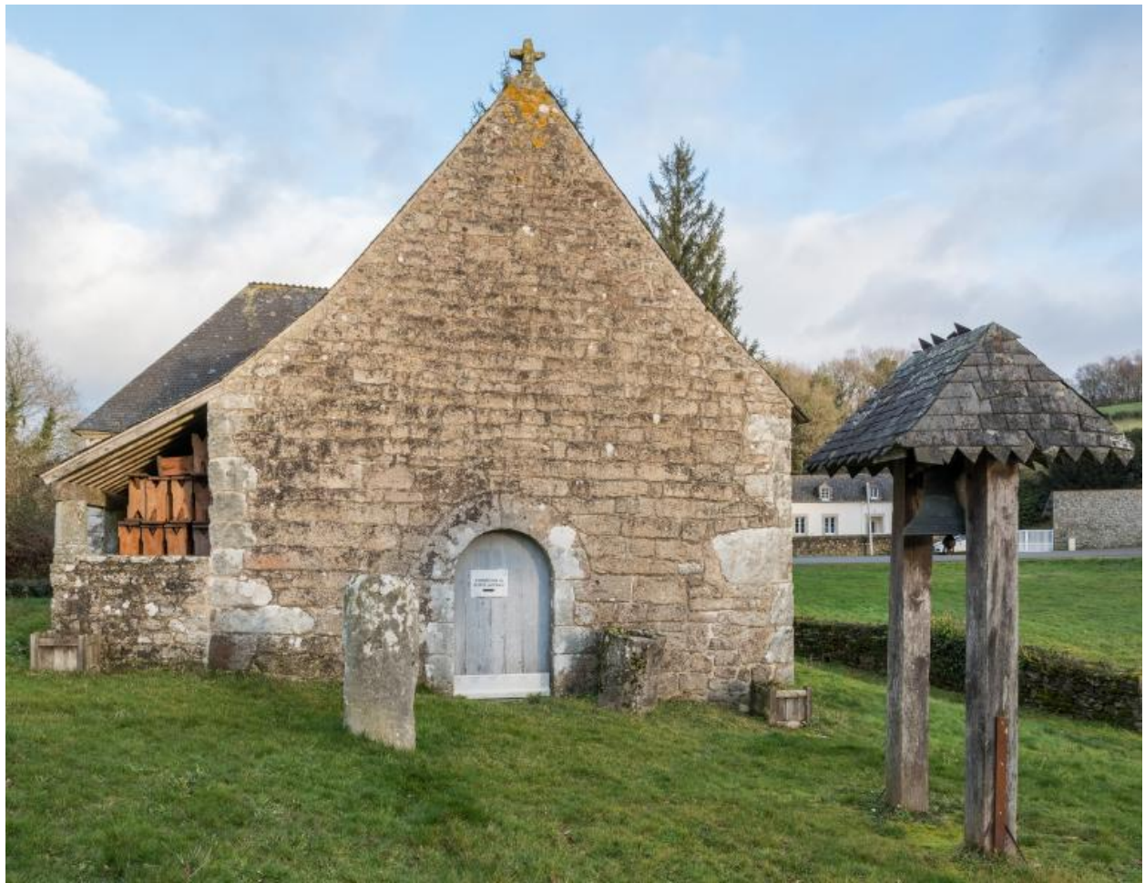
Vue de la façade ouest de la chapelle
