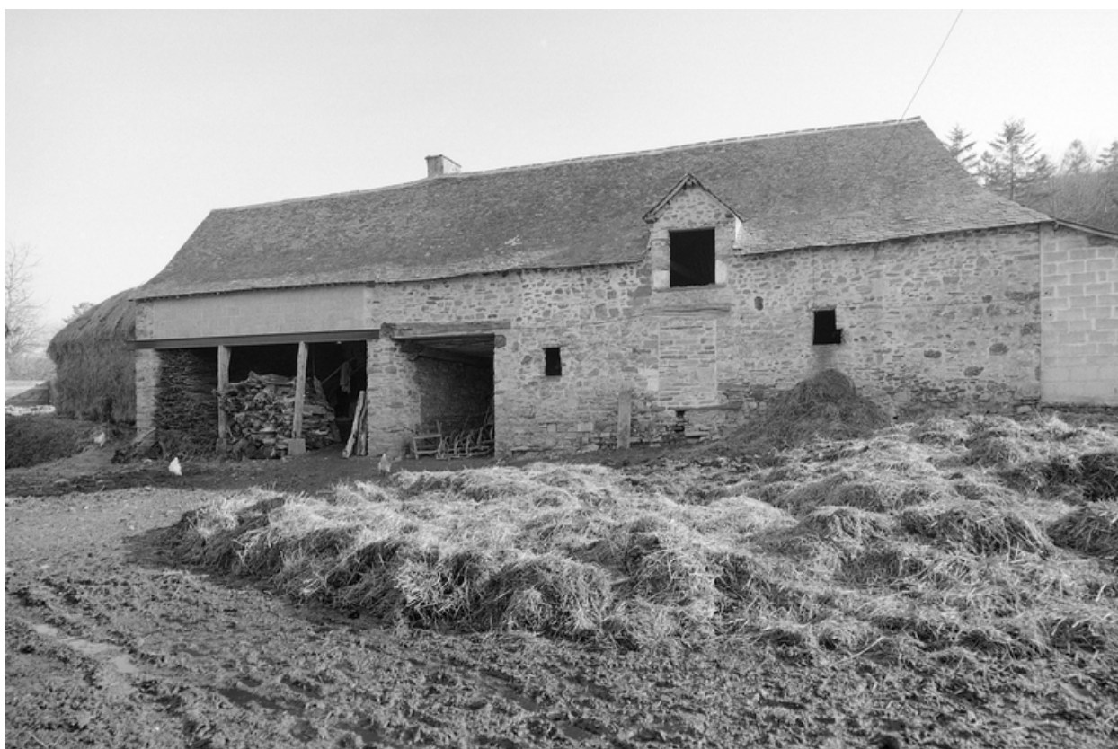
Dépendances, façade sud-ouest.
