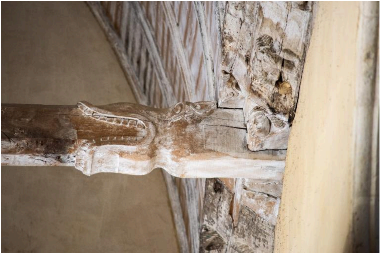
Détail d'un engoulant assemblé sur la sablière nord
