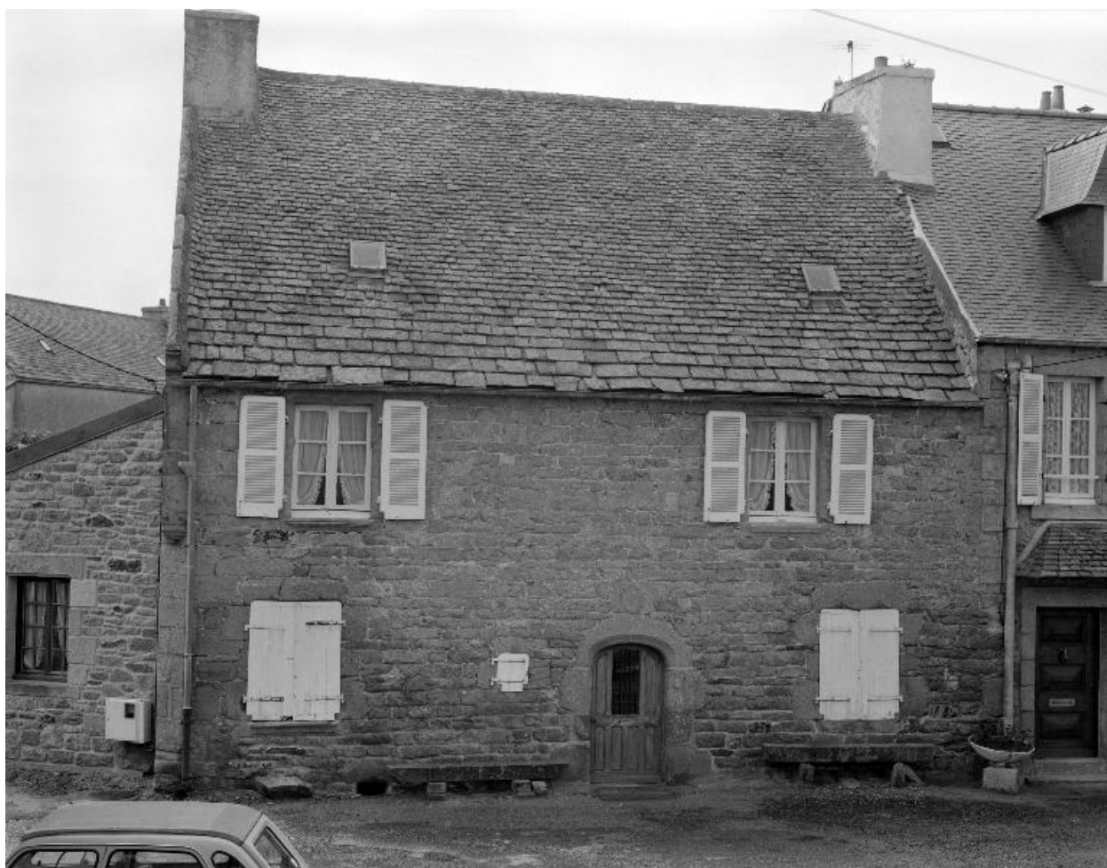
Rue Kléber (A.H.79), élévation nord, vue générale
