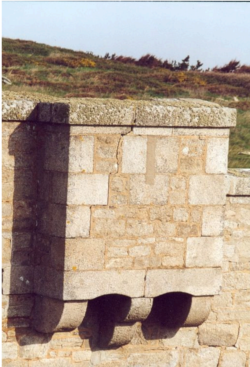
Vue de l'élévation Sud-est : bretèche à trois corbeaux (état en 2000)
