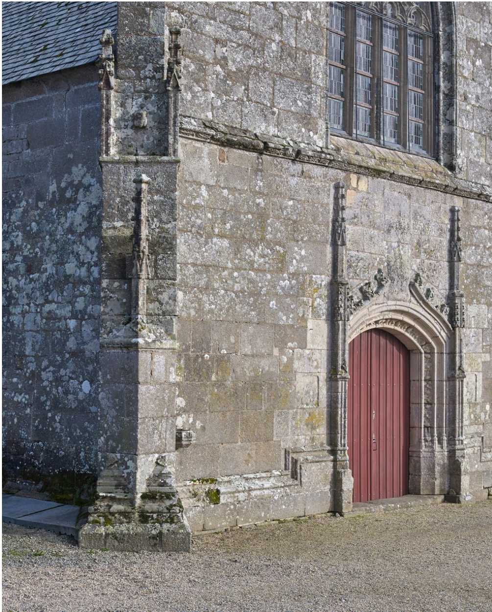
Contrefort nord ouest de l'église
