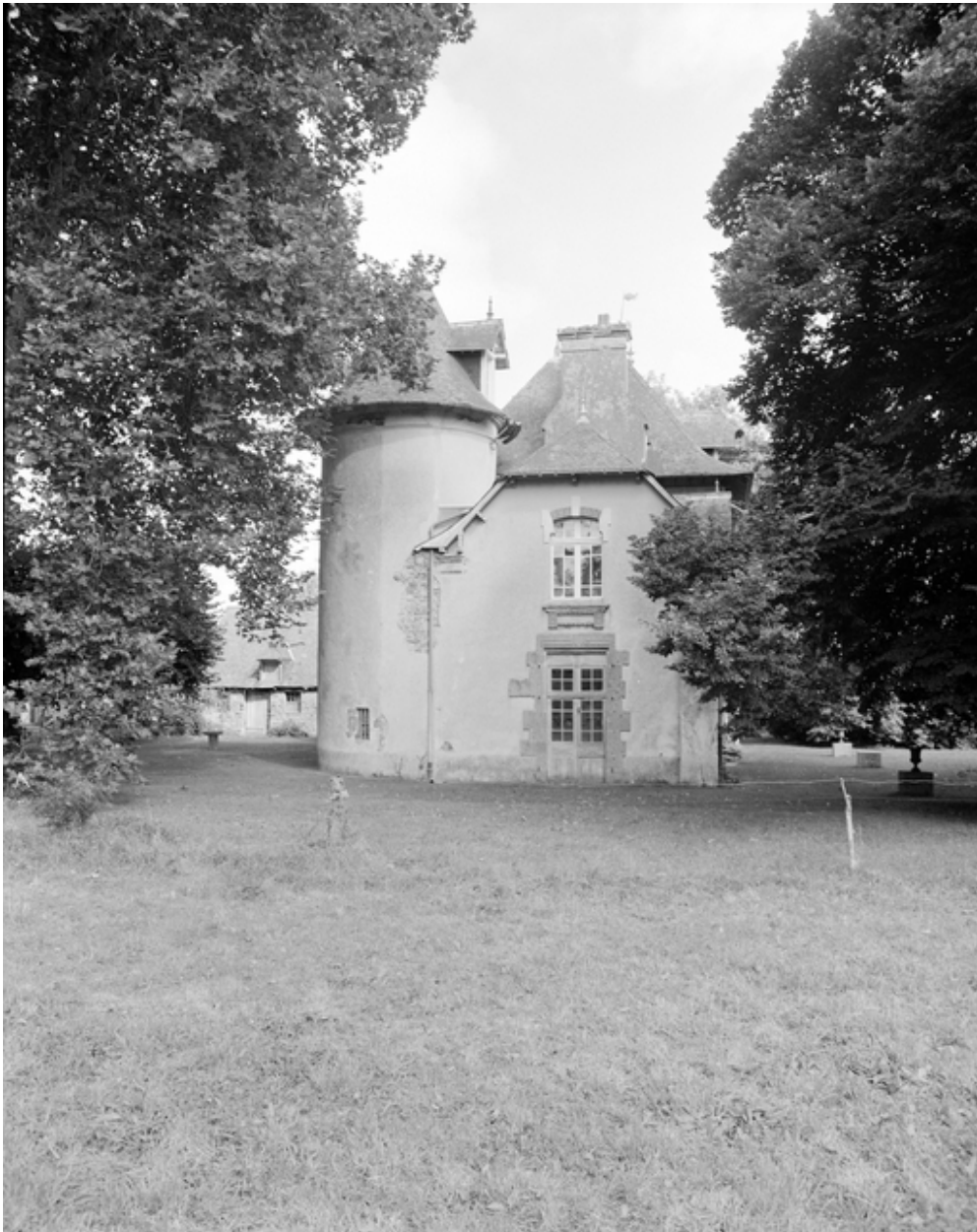
Vue générale sud.
