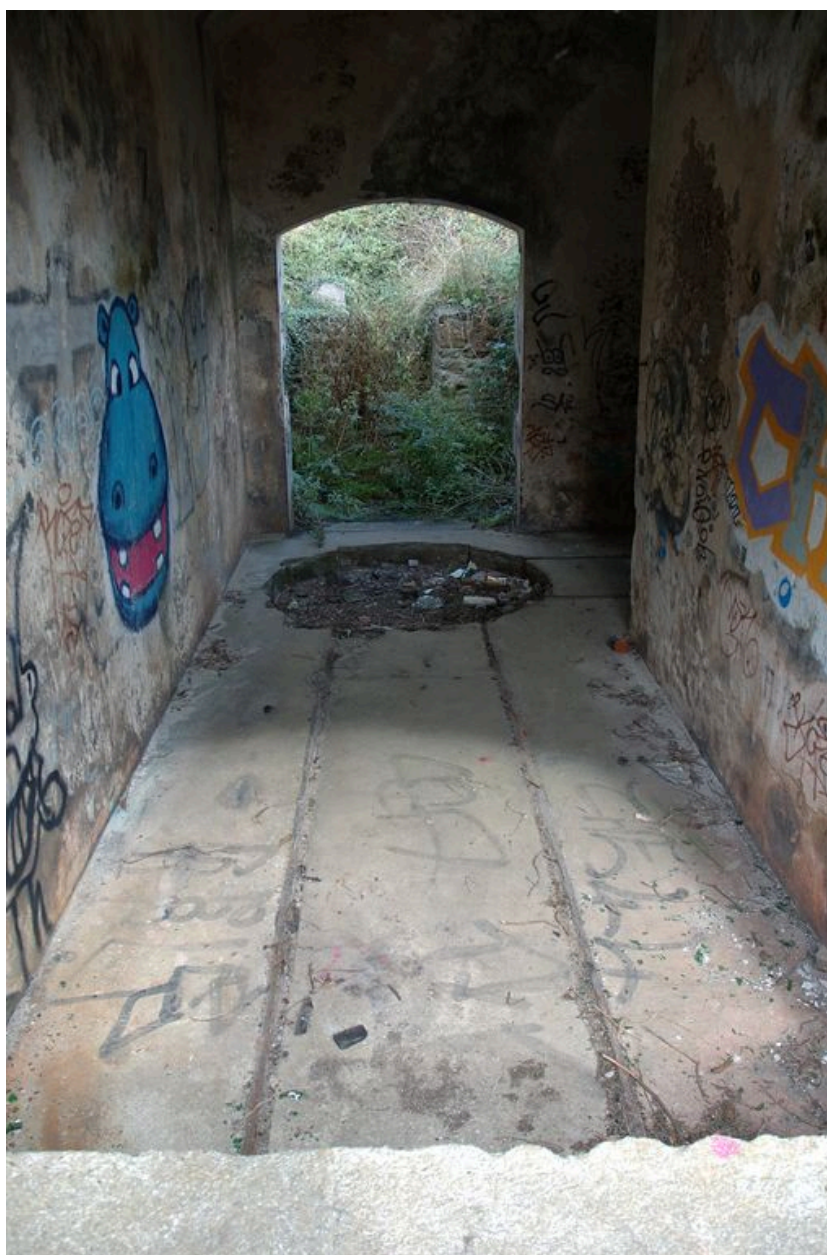
Vue des casemates de projecteur (état en 2007)
