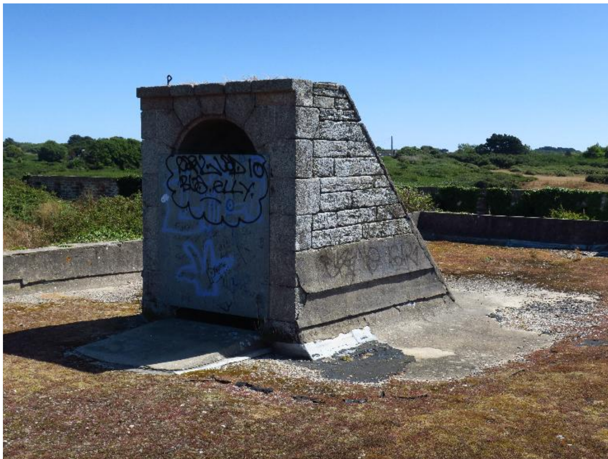
Groix, batterie du Bas-Grognon, corps de garde crénelé, débouché de l'escalier.
