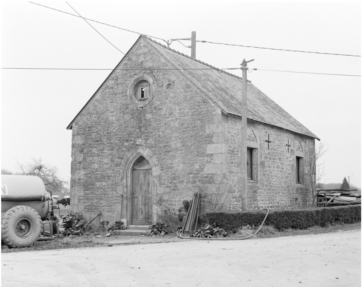
Chapelle, vue générale sud-est.
