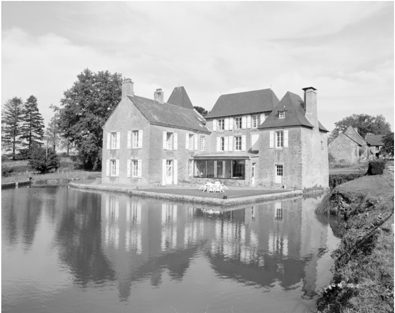
Château, vue générale sud-ouest.
