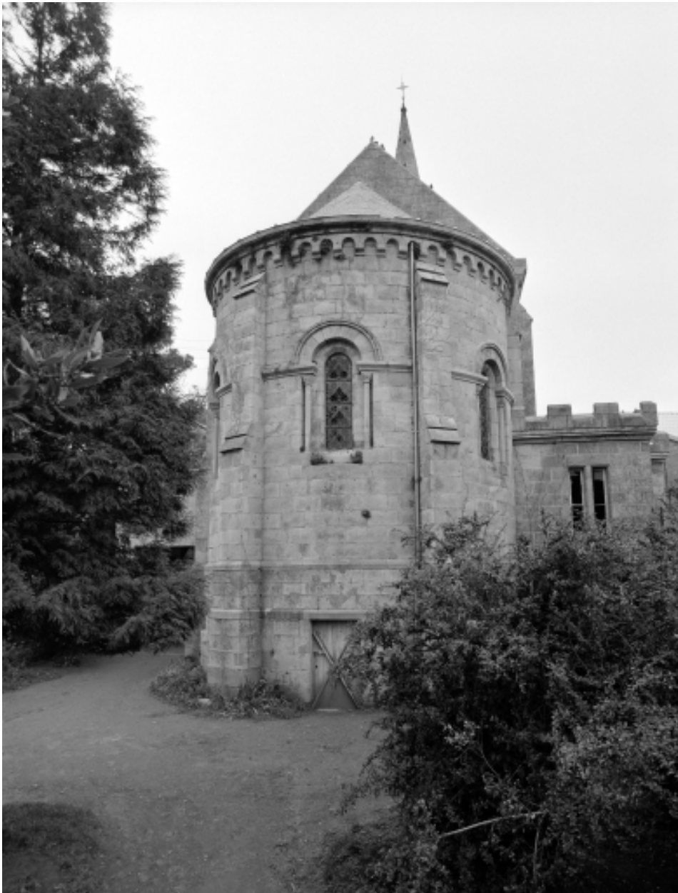
Elévation Est, chevet : vue générale
