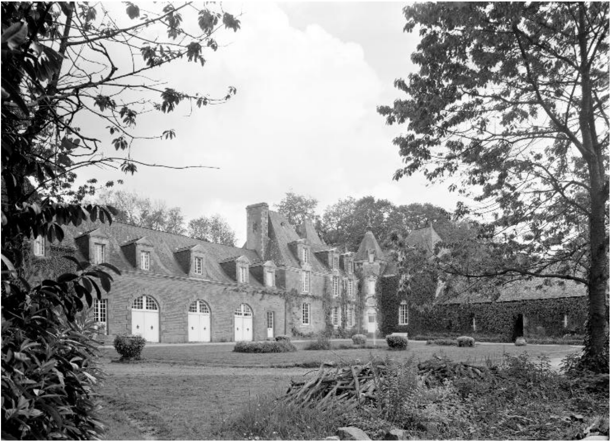
Château vu du sud-ouest (état en 1983)
